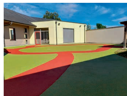
Réfection de la cour du multi accueil
