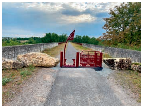
Dans le cadre des travaux de sécurité : mise en place d'une chicane anti moto à l'entrée du viaduc coté rive gauche.
