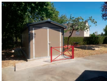
Installation d'un cabanon à l'école maternelle de Beauséjour avec réalisation d'une plateforme et d'une rampe.
