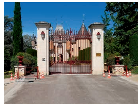
Installation de deux barrières de chaque côté du portail de l'hôtel de ville pour réduire et ralentir le passage des deux roues.
