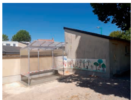
Installation d'un garage à vélos à l'école maternelle Rive Droite
