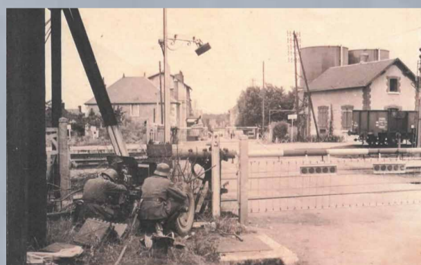
Passage à niveau des rues Pierre Sémard et Henri Massicot
